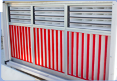
L'air entre par les filtres G4
