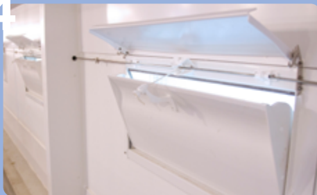
L'air est diffusé dans le bâtiment par des trappes Kanair®
